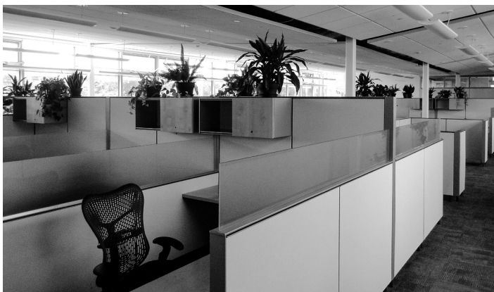
Figure 8. Cloisons à hauteur partielle avec verre givré. Le verre givré n'est pas acceptable, car il interfère avec la vue qu'ont les occupants à travers le vitrage visuel. Photo de Marcus Sheffer.
