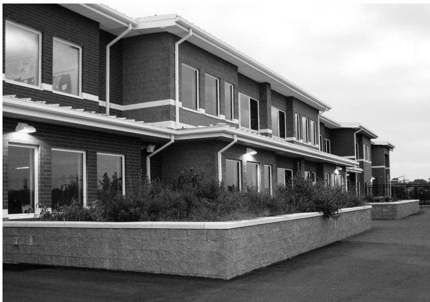
Figure 11. Jardinières à l'extérieur d'une école. Photo de Marcus Sheffer.
